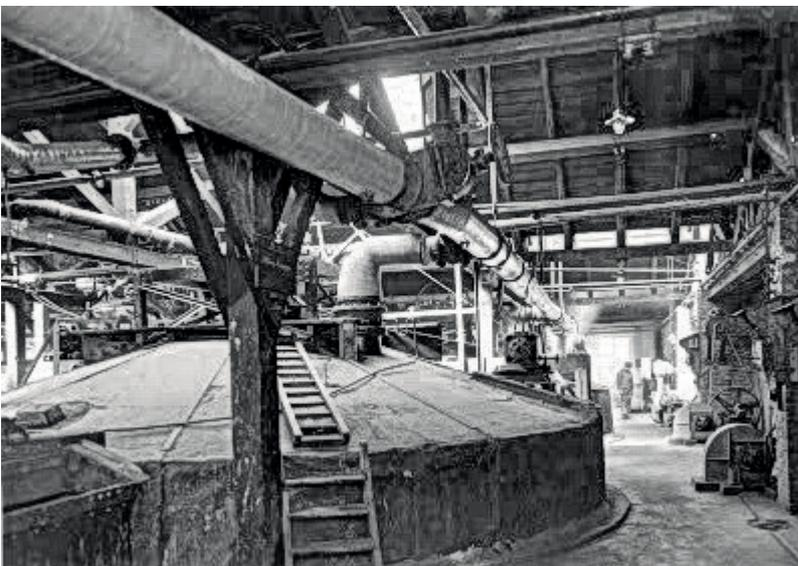
Ces chevalements appelés également sondages, abritaient un mécanisme pour enfiler ces grands tubes d'acier, afin d'obtenir la saumure. Ensuite, les industriels l'acheminaient vers les salines qui faisaient évaporer l'eau en la chauffant dans des grandes poêles et récupéraient ainsi le sel pour le commercialiser.
